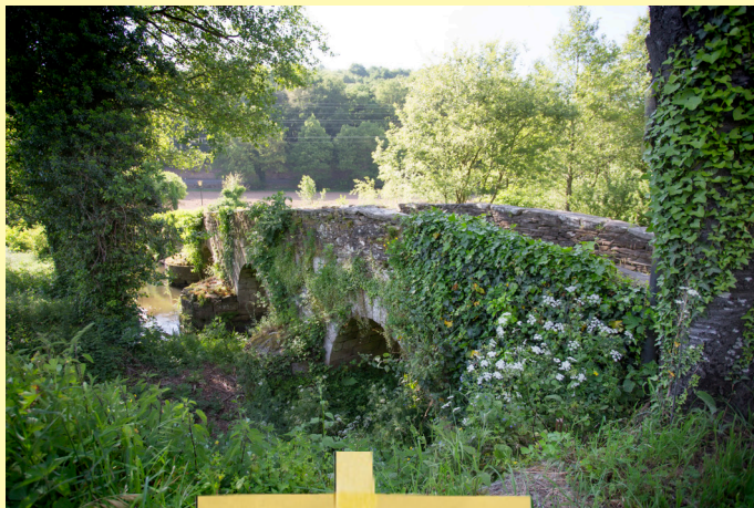
Ponte da Áspera
